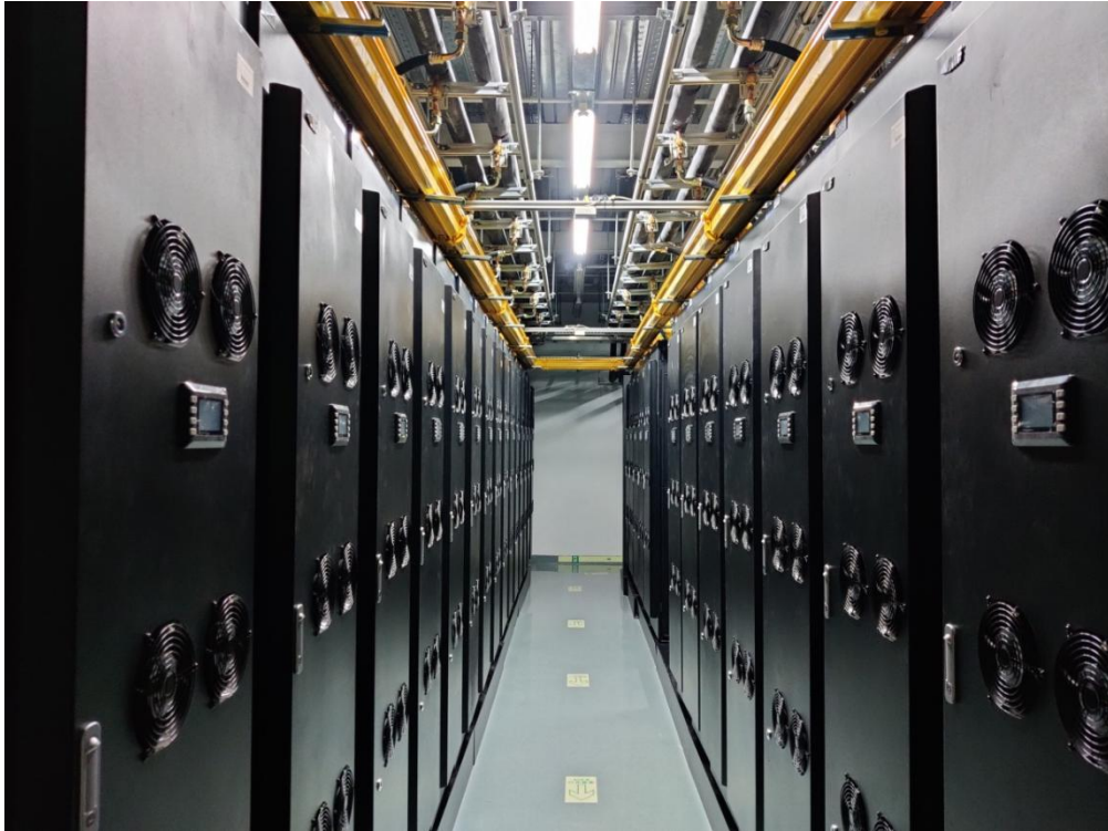
图 146 背板空调末端实拍图
